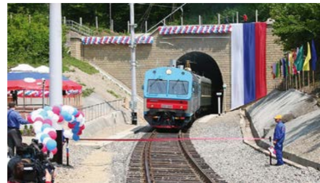
Тоннели участка Армавир–Туапсе Северо-Кавказской железной дороги
