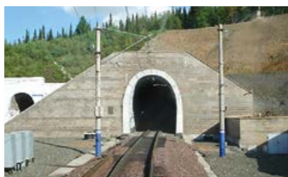
Джебский тоннель, Красноярский край
